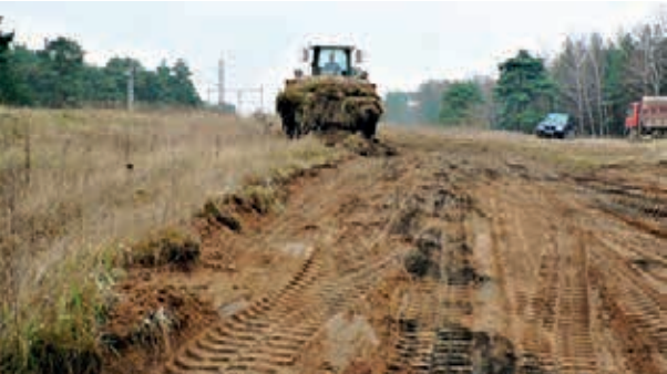
Obr. 1. Velkoplošné strhávání svrchní eutrofizované vrstvy pomocí těžké techniky v roce 2014. (I. Jongepierová)
