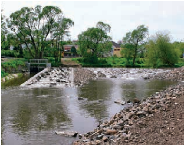
Obr. 6. Jez u prádelny Kyselý po rekonstrukci. Došlo zde k dosypání dolního líce jezu do podoby kamenité rampy a vybudování rybího přechodu. Přechod tvoří betonový žlab členěný příčnými řadami balvanů. (T. Just)
