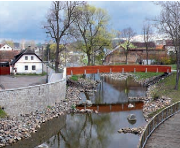
Obr. 4. Přírodě blízká protipovodňová úprava Blanice v historickém středu Vlašimi. Ochranné stěny vymezují říční koridor s přírodě blízkou, kamenitými strukturami členěnou a stabilizovanou kynetou. Patrný jsou nové komunikační prvky – podélná manipulační komunikace a lávka. (T. Just)
