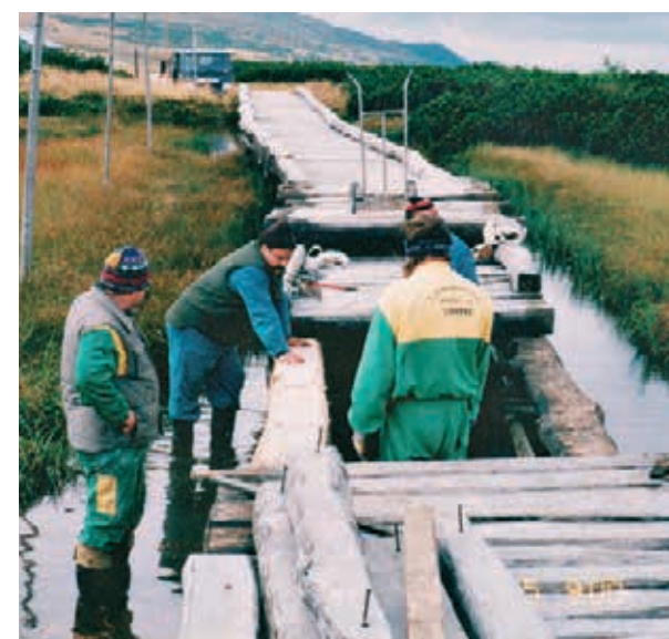
Obr. 6. Oprava povalového chodníku přes Úpské rašeliniště v roce 2000. (J. Harčarik)
