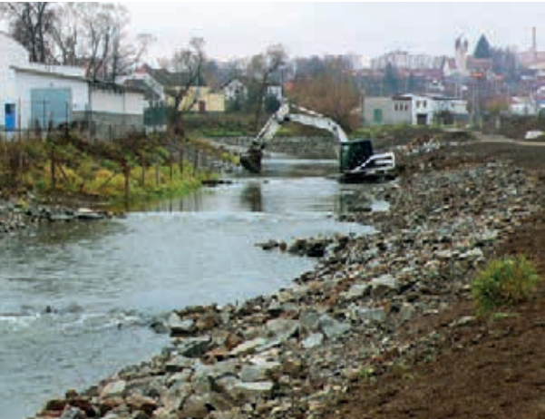
Obr. 3. Blanice na dolním okraji Vlašimi při provádění revitalizace. Po odtěžení úživných zemin ze břehů a rozvolnění koryta byla modelována relativně přírodě blízká kyneta, stabilizovaná a členěná dnovými kamenitými pasy a výhony a strukturami kamenných pohožů. (T. Just)
