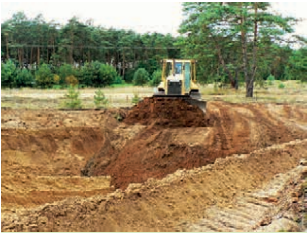
Obr. 7. Obnova vátých písků v PP Vojenské cvičiště Bzenec v roce 2013. Eutrofní vrstvy jsou převrstvovány oligotrofním pískem. (I. Jongepierová)
