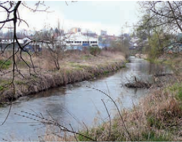
Obr. 1. Blanice na dolním okraji Vlašimi před revitalizací. Koryto bylo geometrizované technickými úpravami, břehy byly pokryté úživnými zeminami s ruderalní vegetací. (T. Just)
